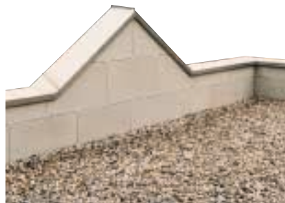
Dakopstanden geïsoleerd met Styrodur LDE
